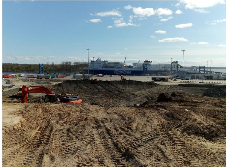
Um das Gelände der Teilfläche 3 auf das östlich anschließende Hafenniveau abzutragen, wurden insgesamt rd. 400.000 cbm Boden bewegt. Die Böden bestehen aus eiszeitlichem, bindigem Geschiebemergel. Der Boden wurde abgetragen und in eine ehemalige Kiesgrube am Dummersdorfer Ufer eingebaut. Die Urgeländehöhe von bis zu 19,00 m üNN wurde auf eine Höhe von ca. 4,00 – 5,00 m üNN niedergebracht und an das bestehende Hafenniveau angepasst.
